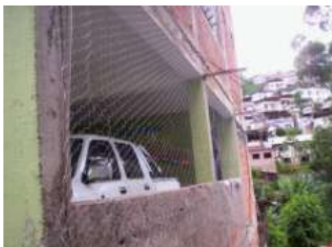
Figura 12. Tela na mureta da garagem.
