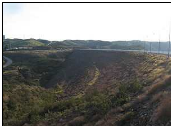
Fotografia -1: Degradação ambiental. Fonte: O Autor (2009).
