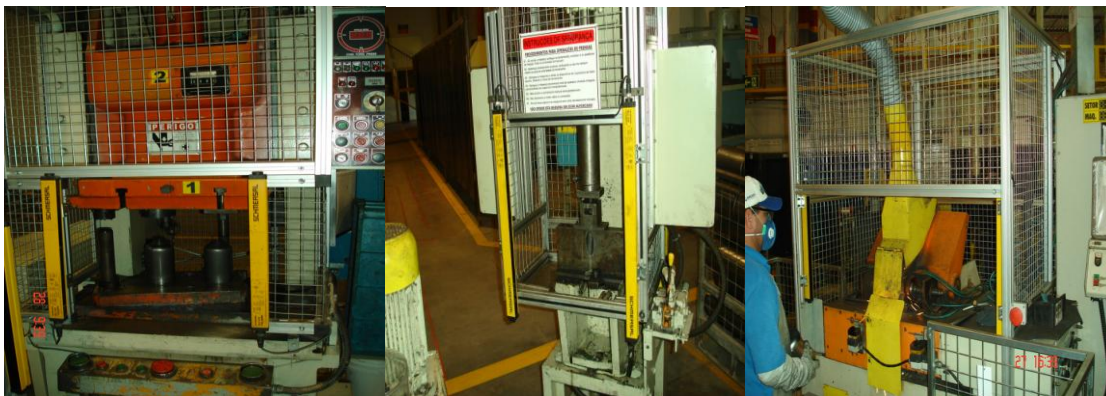
Figura 2: Sequência de fotos demonstrando os sistemas de segurança instalados nas prensas e no dispositivo pneumático. Fonte: Kidde Brasil S.A. (2011).
